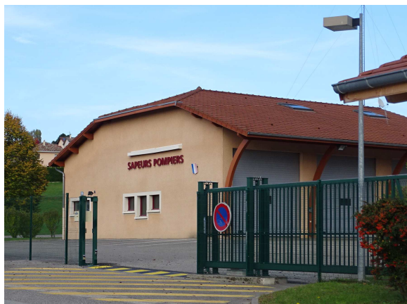
Centre de première intervention de Ruy (rue de Lavitel)
