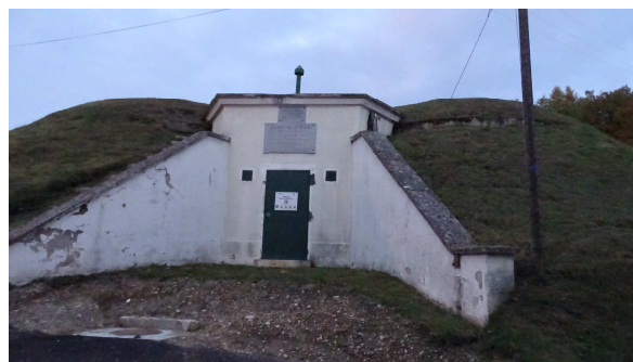
Réservoir - Route de Montceau
