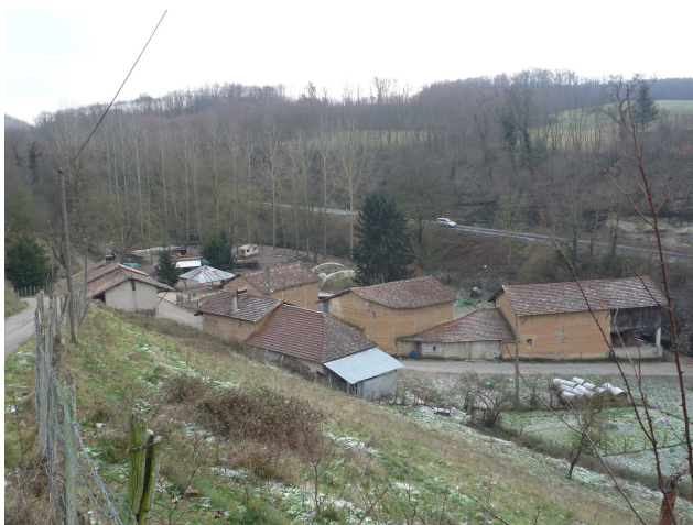
Encaissement au lieu-dit "Charlan"
