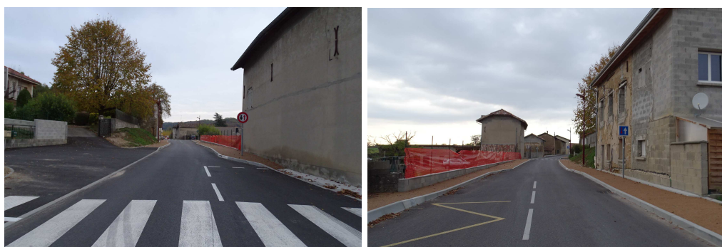
Travaux d'aménagement de la route de Châtonnay
